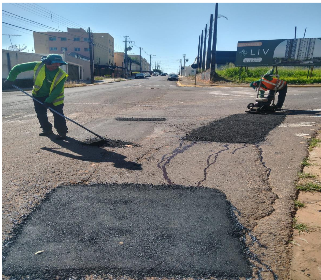
TAPA BURACOS – PROLONGAMENTO RUA PADRE JOÃO GOETZ – JARDIM CINQUENTENÁRIO
