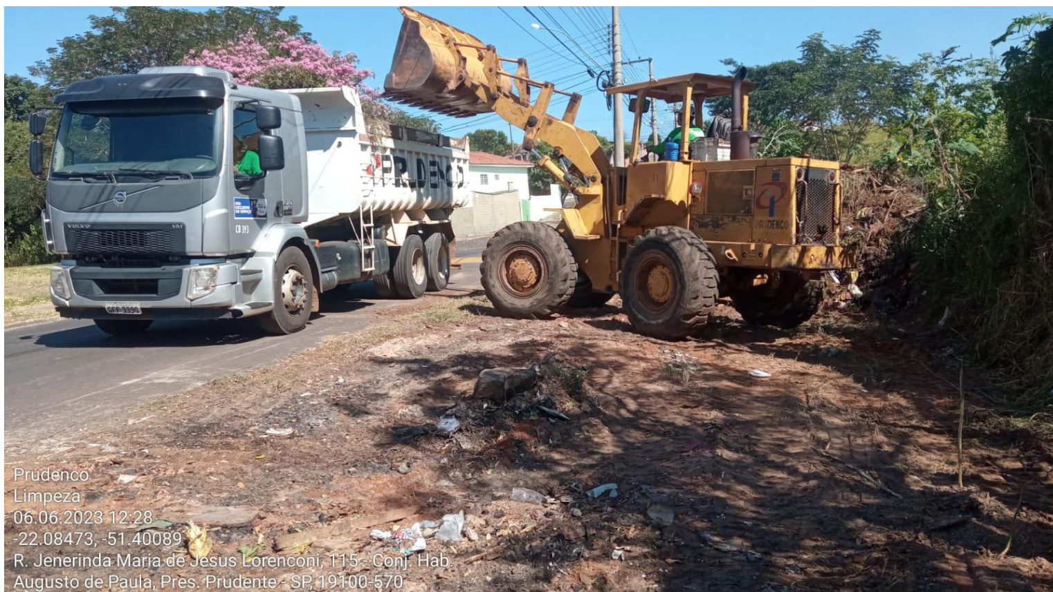
LIMPEZA MECANIZADA - AV MANOEL ROMEU CAIRES ( AUGUSTO DE PAULA )
