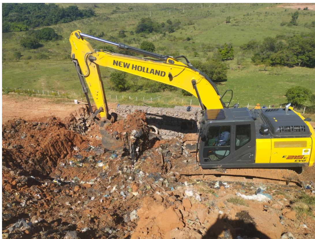
OBRAS ATERRO SANITÁRIO
