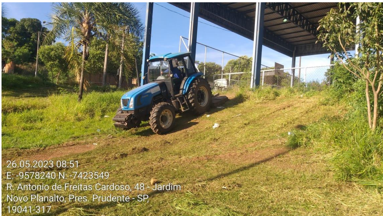
Limpeza Mecanizada, Quadra Coberta – Jardim Brasília
