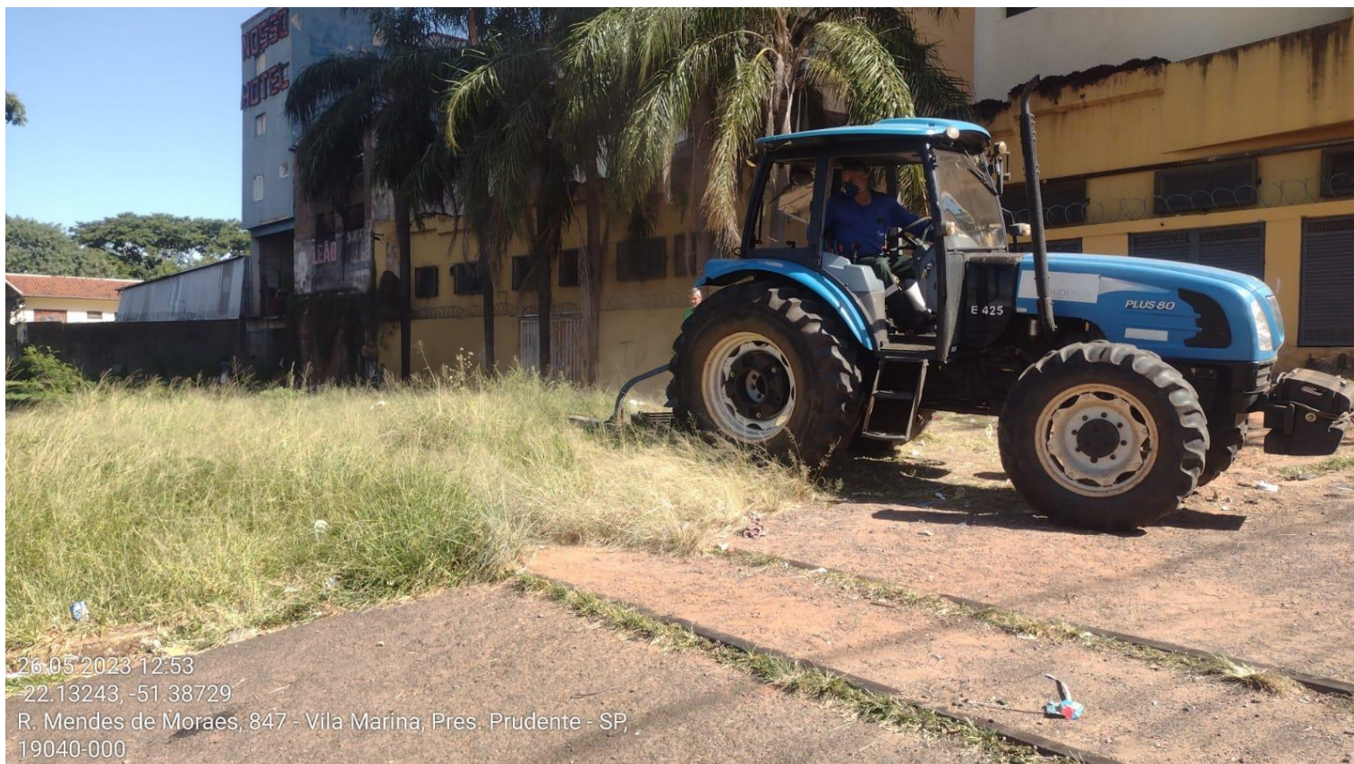
Limpeza Mecanizada – Linha Férrea
