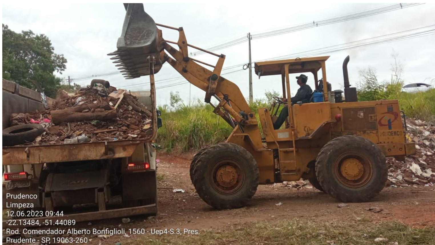
Limpeza Mecanizada – Jardim Itaipu
