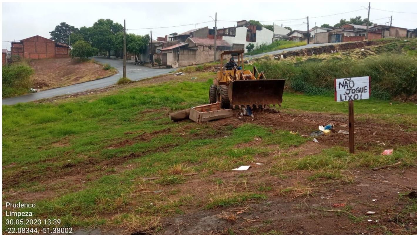
Limpeza Mecanizada – Area Pública Jd Bela Vista
