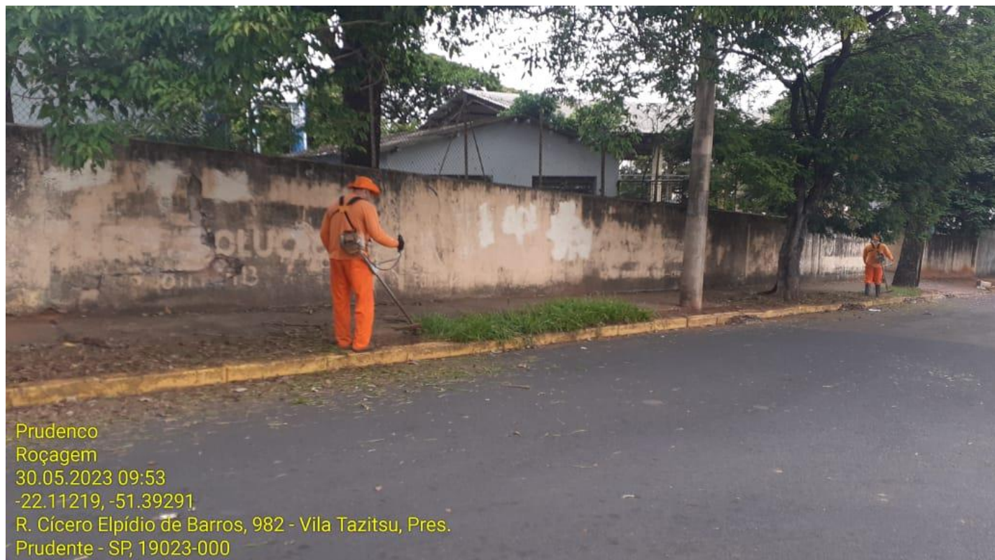
Roçagem e Limpeza – Calçada Escola Hugo Miele
