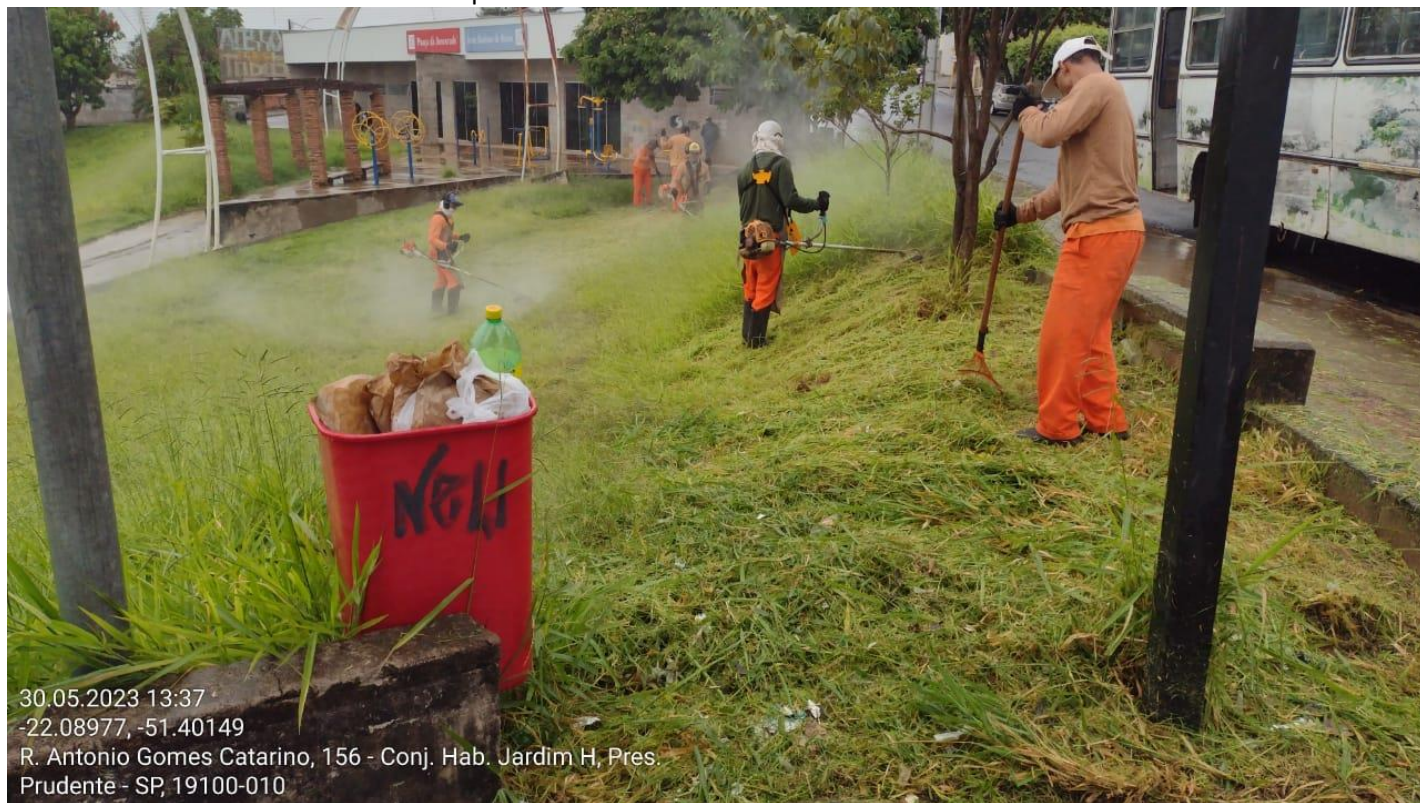
Roçagem e Limpeza – Rua Antônio Gomes Catarino
